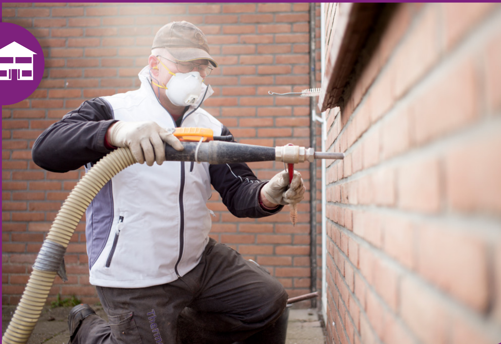
Spouwmuur isolatie bij huurwoning in Vlissingen. Foto: Evert van Moort/HH
