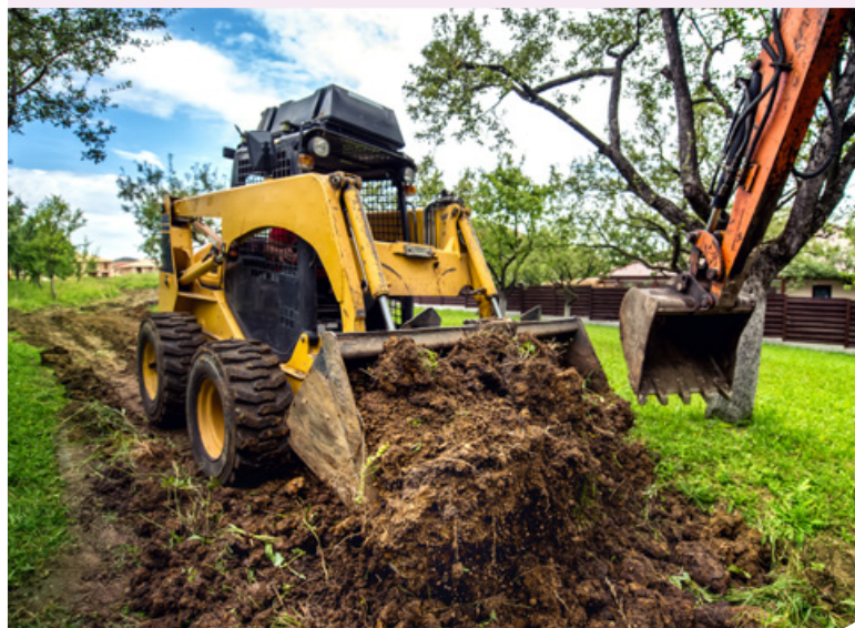
Door anders te werken kan er 10 procent brandstof bespaard worden bij het werk met bulldozers en graafmachines. Foto: Shutterstock
