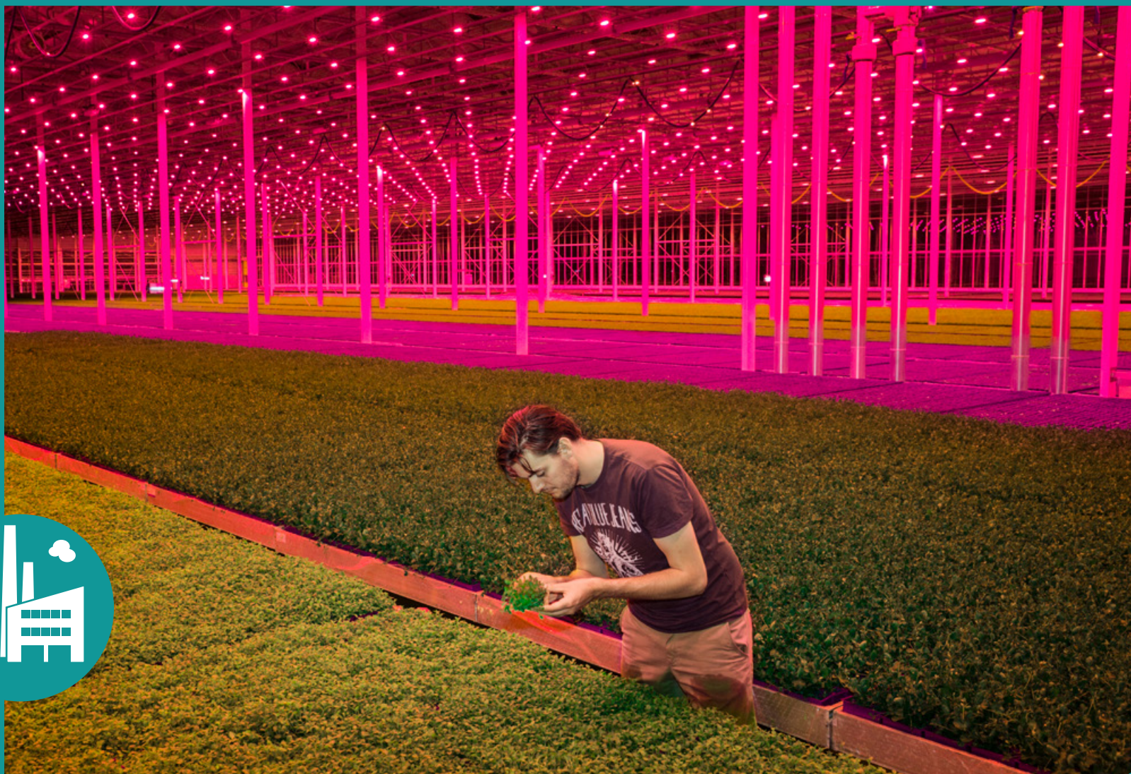
Rode led-lampen in de kassen van Koppert Cress. De lampen behoren tot de meest efficiënte in de tuinbouw. De warmte die vrijkomt bij de led's wordt afgevoerd naar een thermische opslag. Foto: Frans Lemmens/HH
