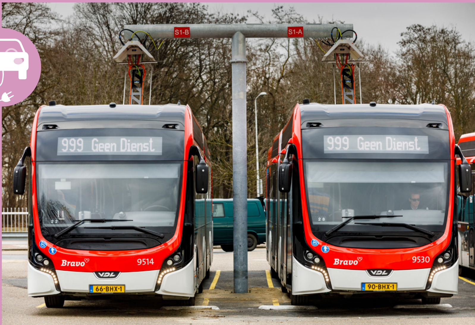
Elektrische bussen aan de laadpaal. De vloot van Bravo (Brabants openbaar vervoer) bestaat uit 43 elektrische bussen en 65 uitstootarme dieselbussen. De elektrische bussen moeten na ongeveer drie uur gebruik aan de laadpaal. Het schema van de chauffeurs is daarop aangepast. Foto: Chris Pennarts/HH
